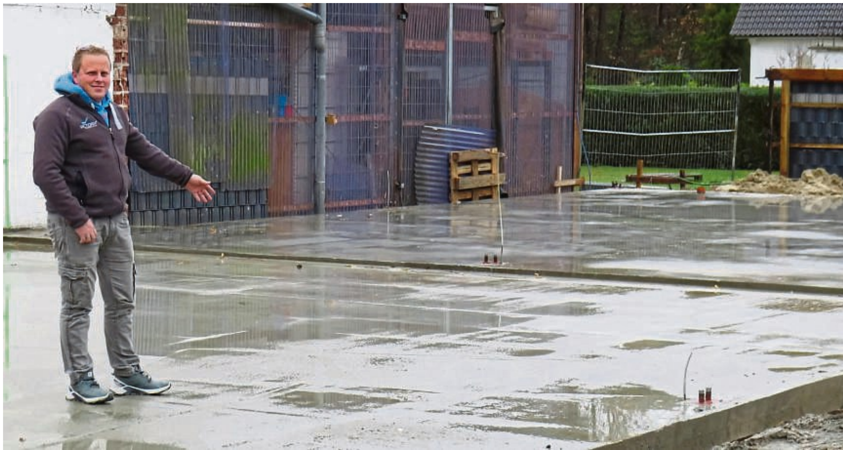
Das Fundament steht: Thorsten Bobrink präsentiert den Ort, an dem der insgesamt 240 Quadratmeter große Anbau des Zweiradfachhändlers seinen Platz haben wird. Im Februar soll die neue Werkstatt mit Lager fertig sein. FOTO: JANNICK RIPKING
